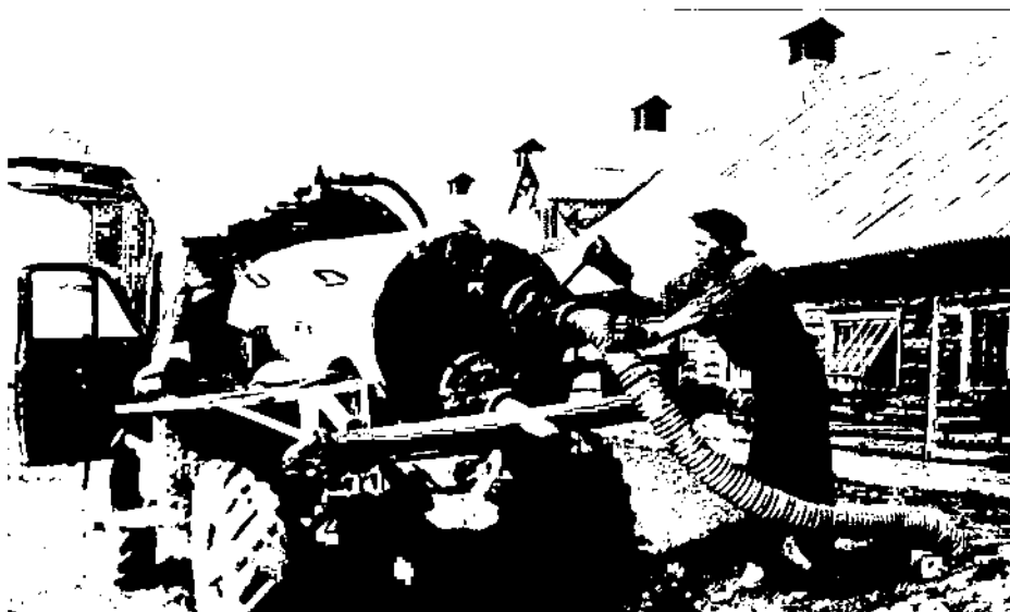
Механизированная очистка стоков животноводческой фермы
