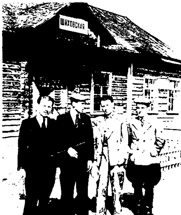
Послевоенный железнодорожный вокзал в п. Шаховская, пока строилось нынешнее здание, временно размещался в бывшем жилом доме
