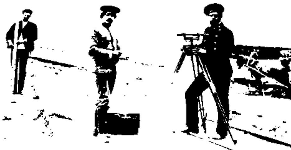
Проектировщики. Строительство пути
